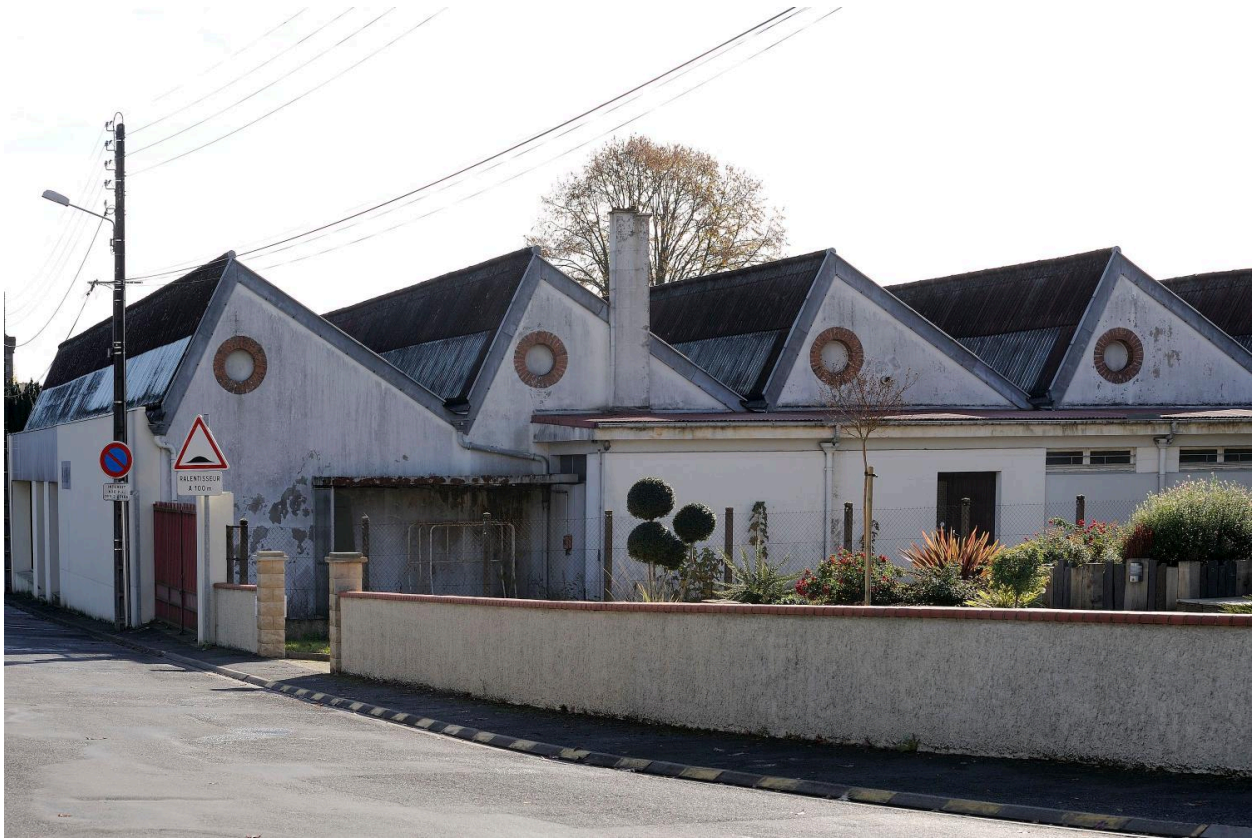
Vue générale de l'usine.
