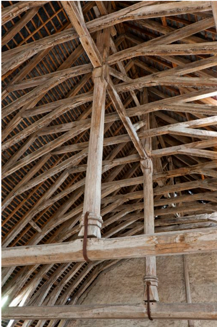
La charpente à chevrons-portant-ferme.
