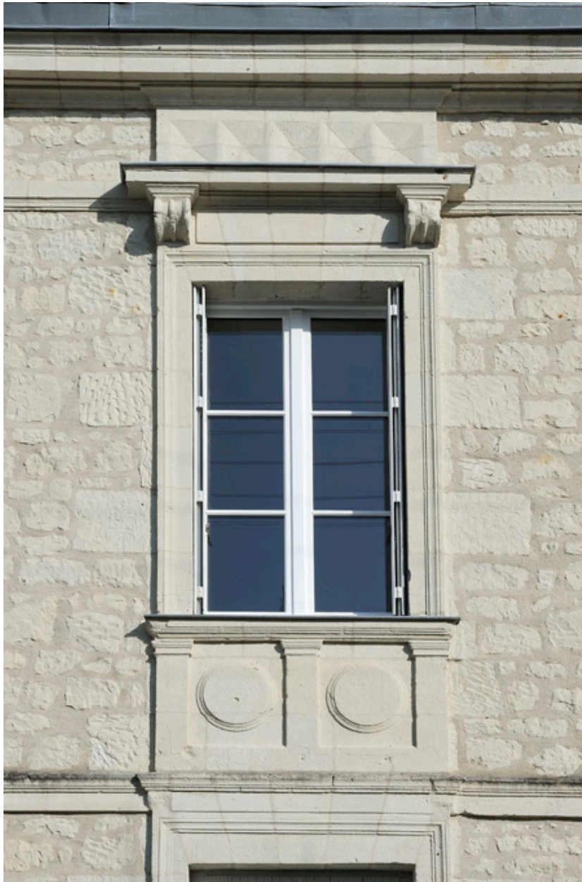
Maison de la directrice : baie de l'étage
