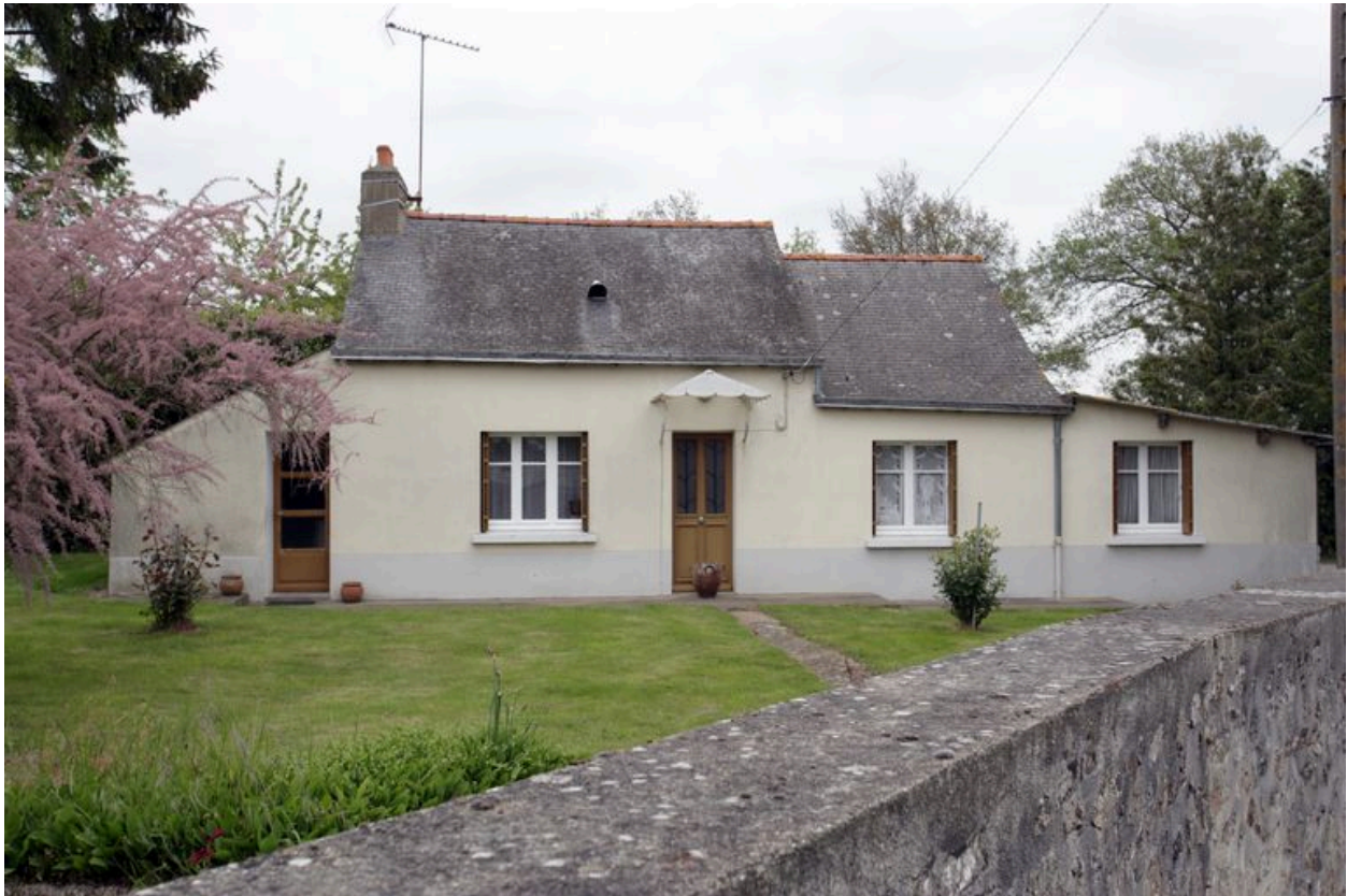
La façade principale.
