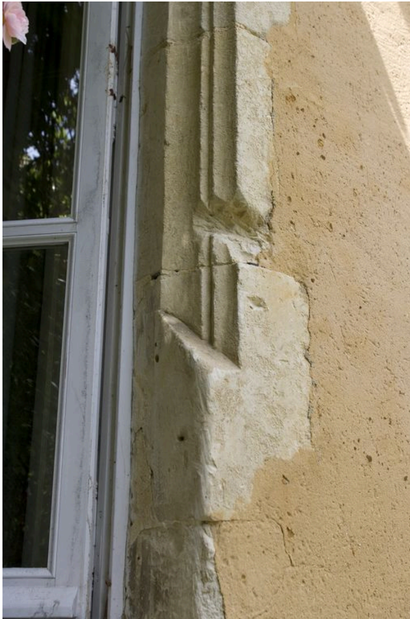
Logis, détail de la baie gauche de l'élévation sur jardin.
