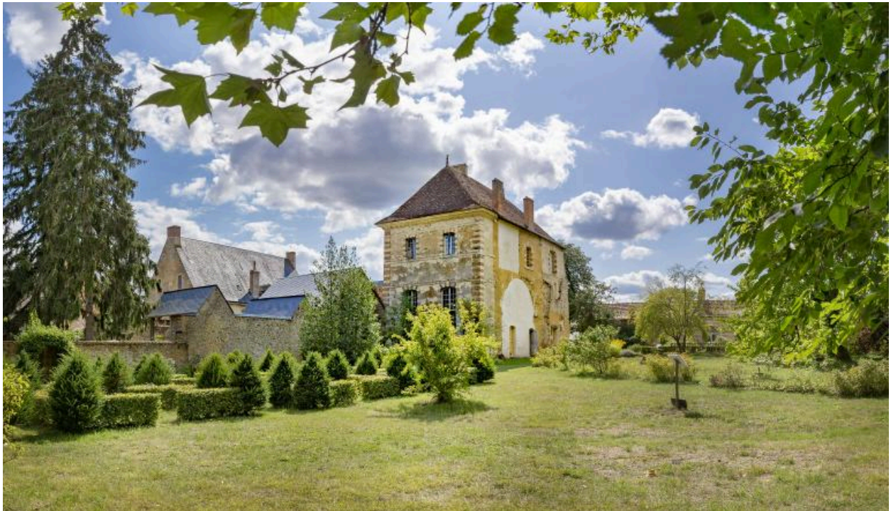
Les bâtiments du prieuré depuis le jardin.
