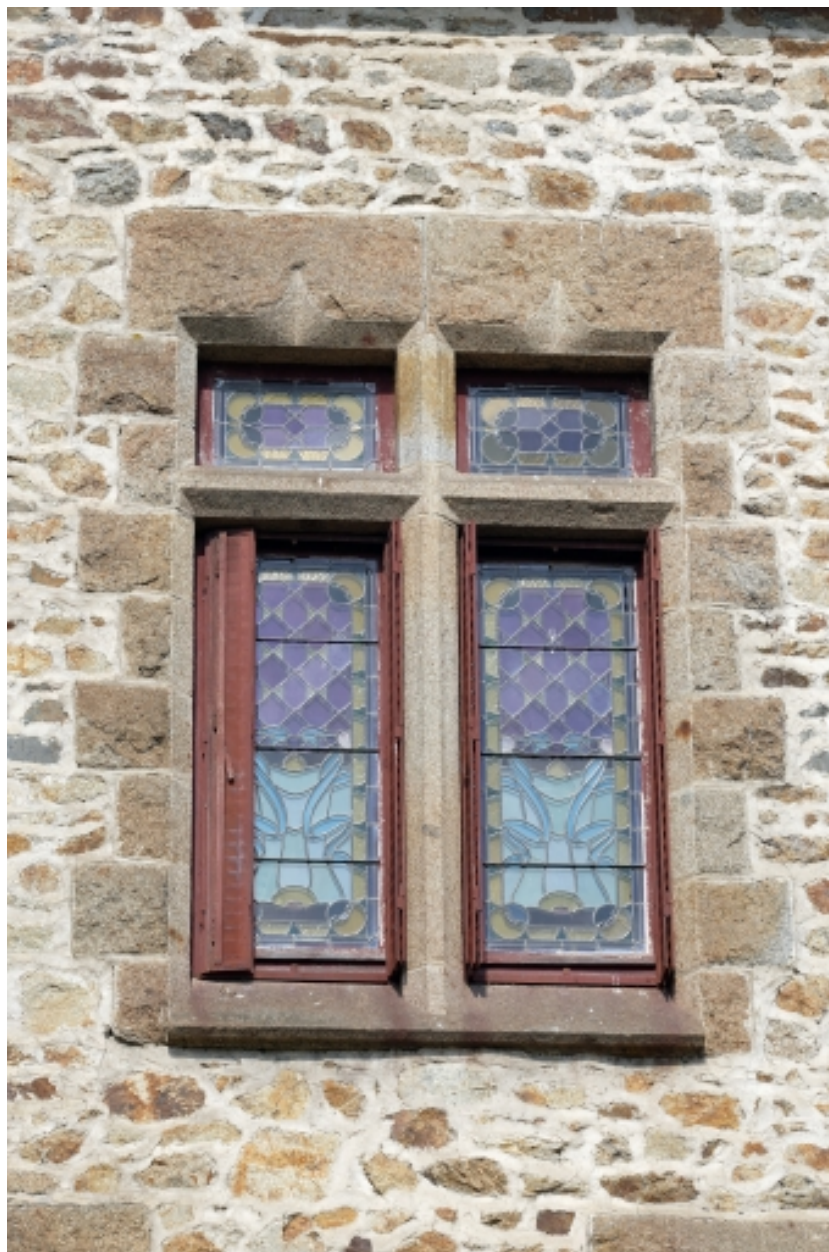
Détail de l'élévation est de la maison : fenêtre nord de la chambre principale.
