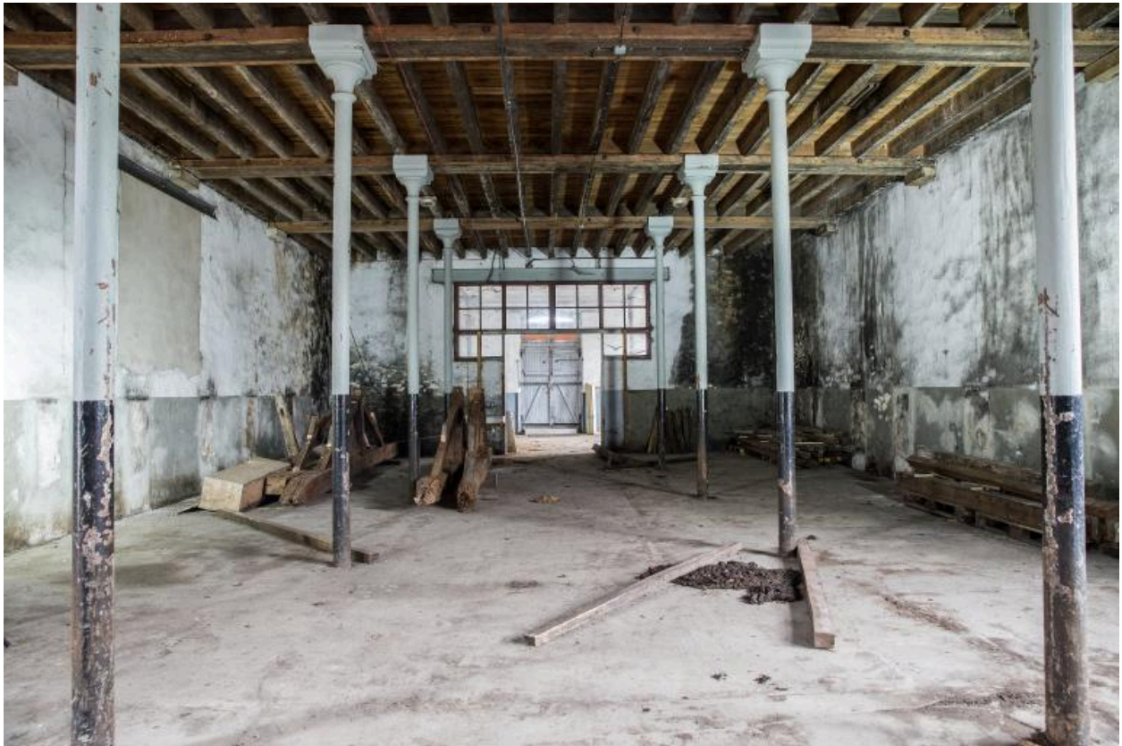
Intérieur du chai nord, vue de la file de poteau en fonte, 2018.
