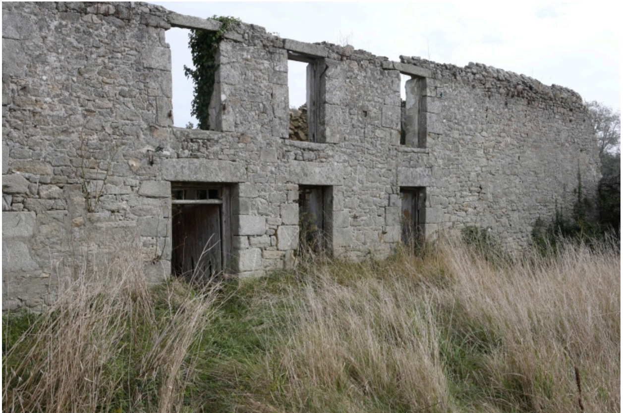
Logis. Aile sud. Façade sud.
