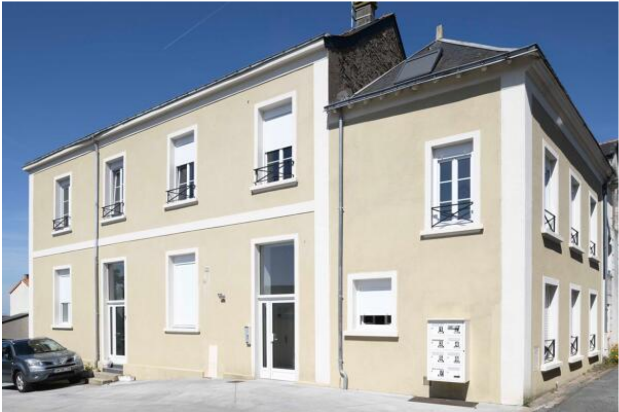
Vue de l'ancienne mairie-école depuis la rue.
