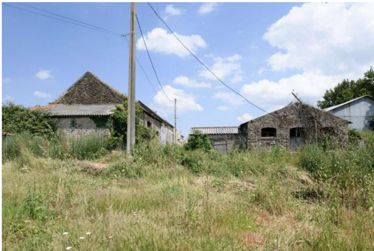
La longère n° 2 et la porcherie. Vue depuis le sud-ouest.
