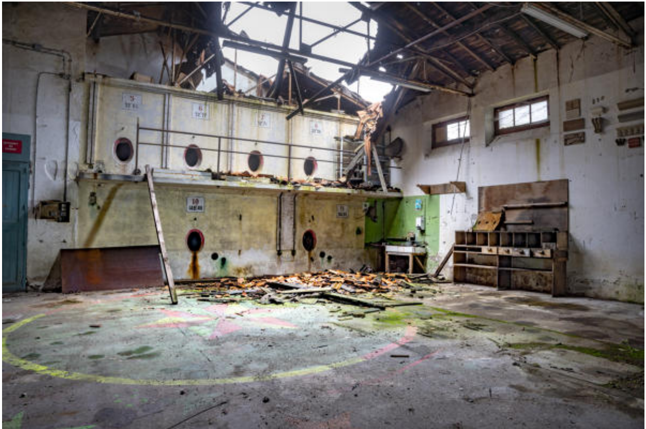
Cuverie principale, vue des superpositions de cuves en partie ouest.
