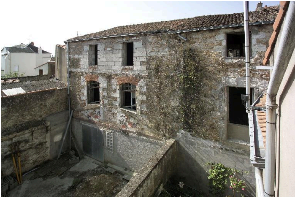
Maisons n° 10 et n° 12 : les façades postérieures prises du côté du quai.
