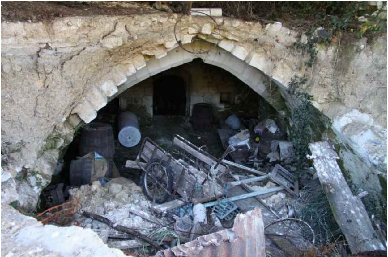
Le logis, la cave : voûte de pierre.
