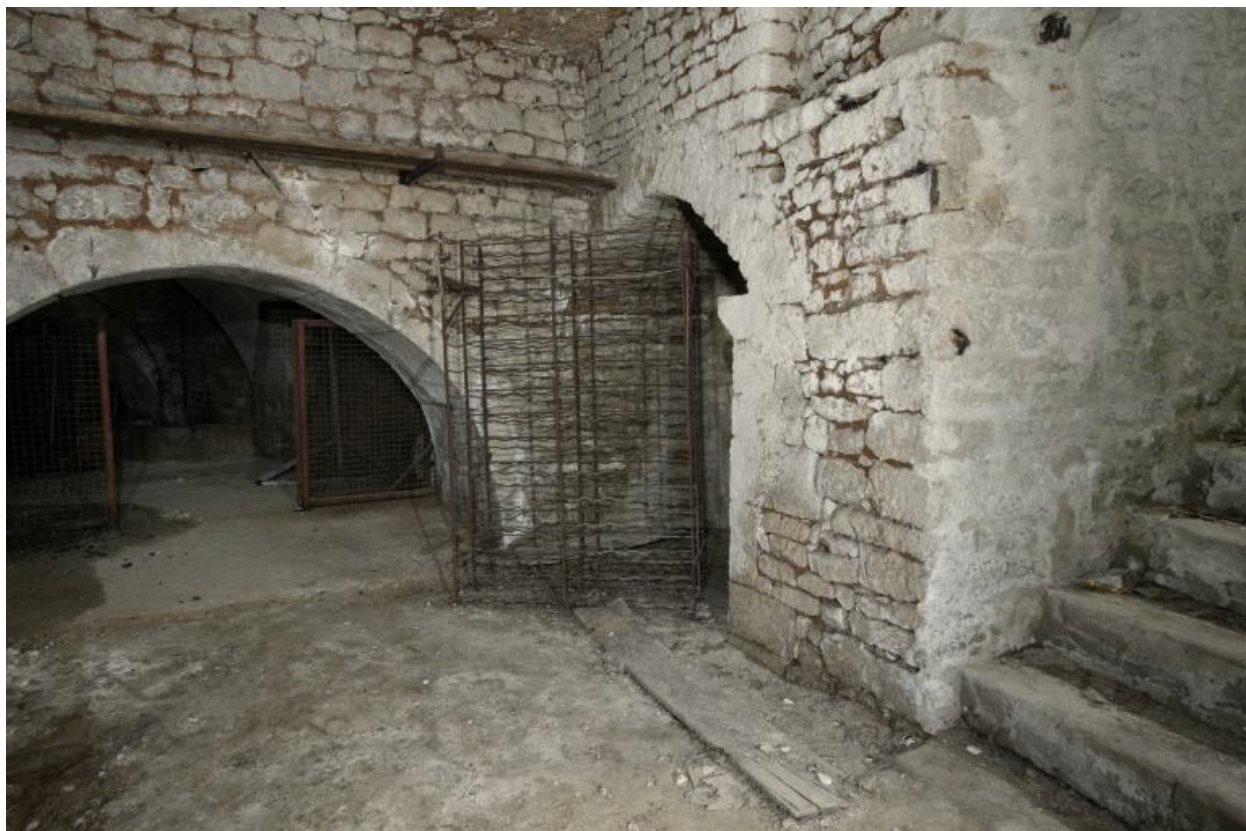
Sous-sol du bâtiment perpendiculaire à la chapelle.
