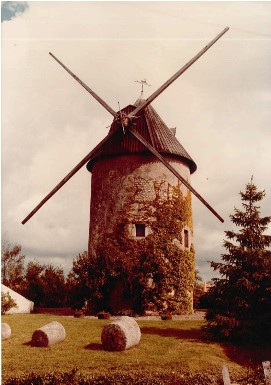
Le moulin vu depuis le sud en 1988.
