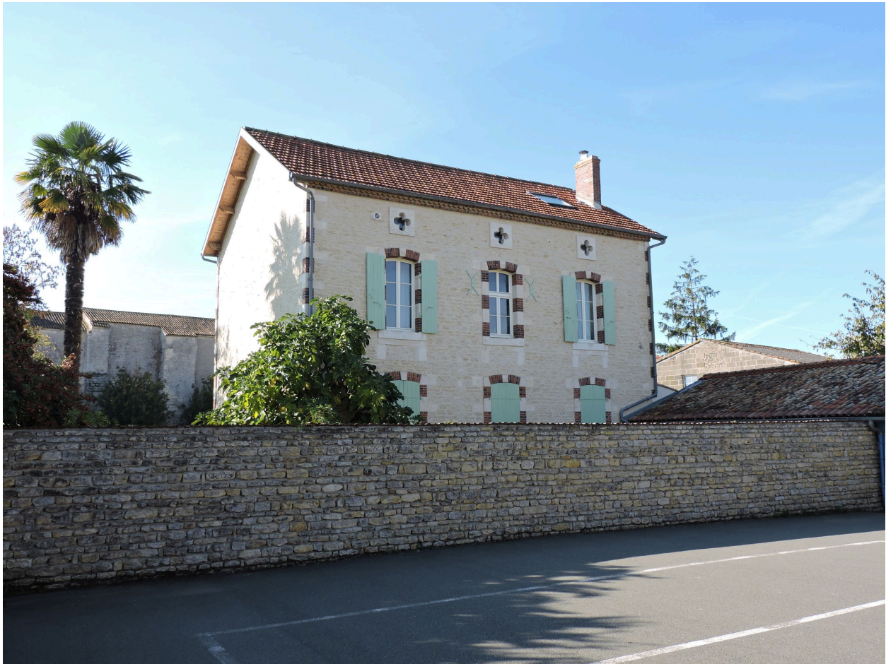
L'ancien logement vu depuis le nord-est, séparé de la cour sud par un mur de clôture.
