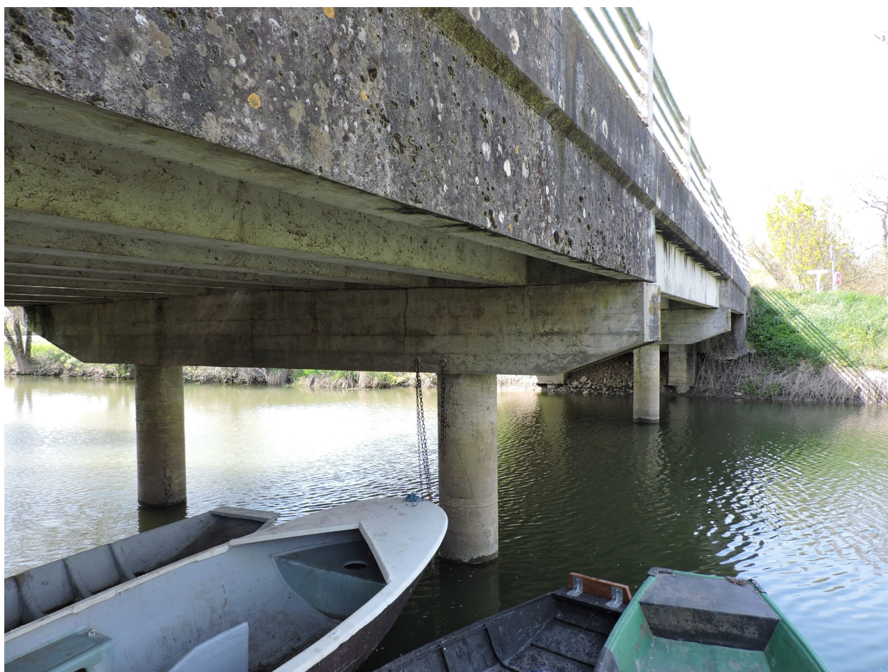
Détail du pont et de ses piles.
