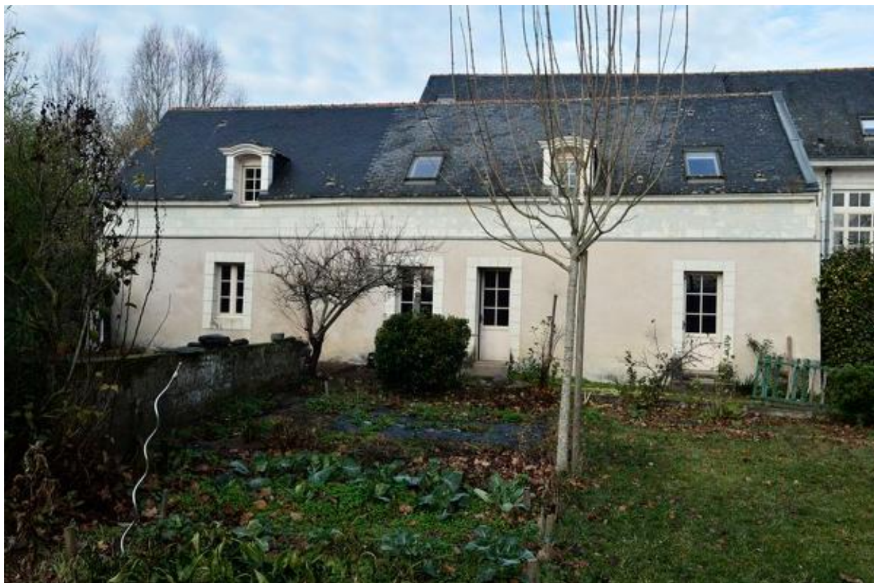
Maison à gauche du bâtiment principal.
