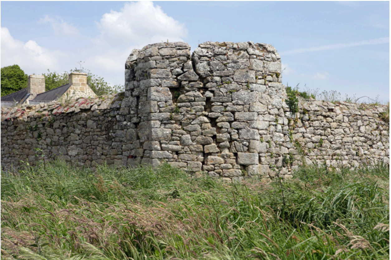
Cour. Vue de la tour octogonale depuis le sud.
