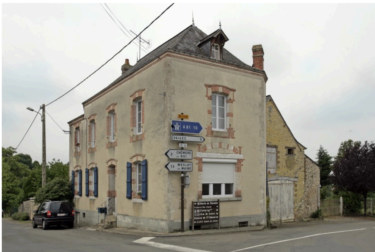
Vue depuis la rue à l'est.
