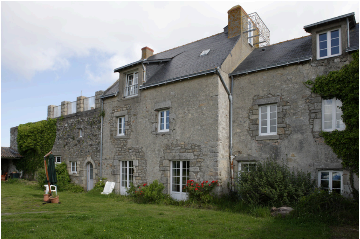
Logis. Vue de trois-quarts de la façade sud.
