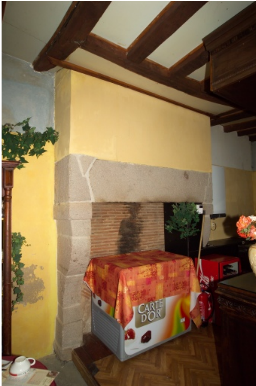
Cheminée sud du premier étage.
