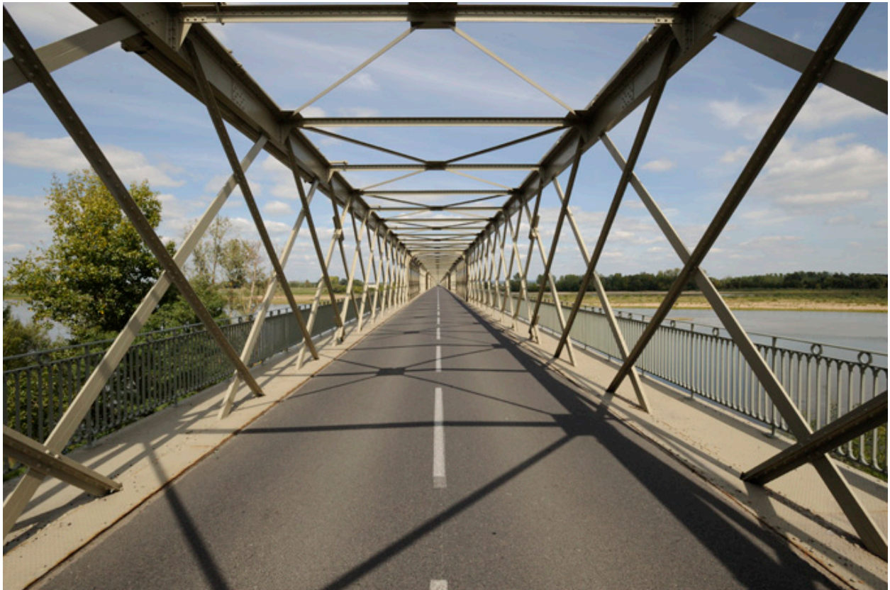
Vue du tablier et de la cage.
