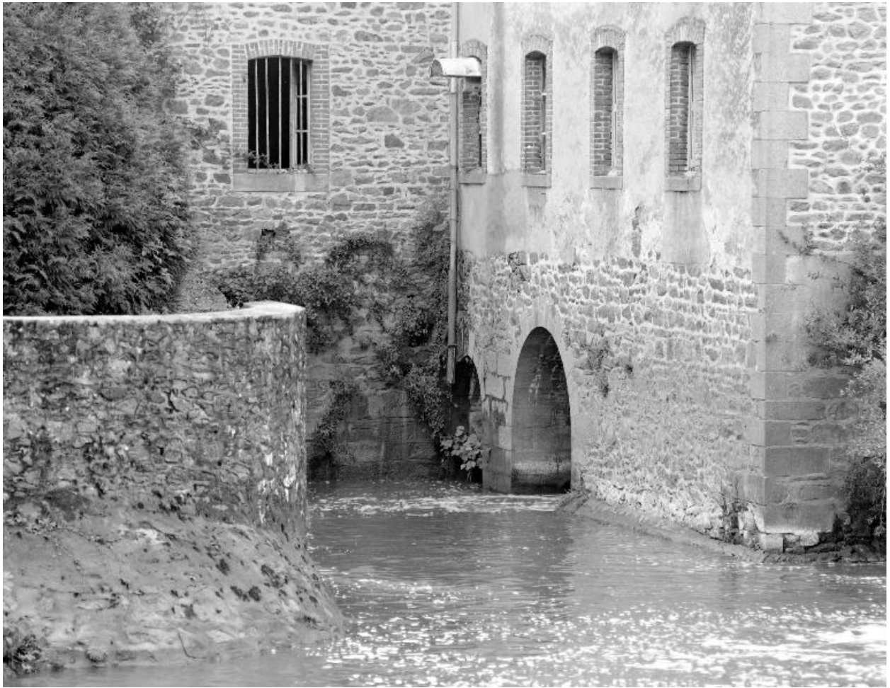
Les deux sorties d'eau et le canal de fuite.
