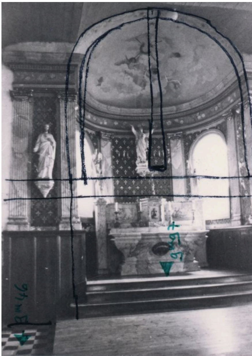
Vue du chœur vers 1973, montrant le décor peint sur la voûte.
