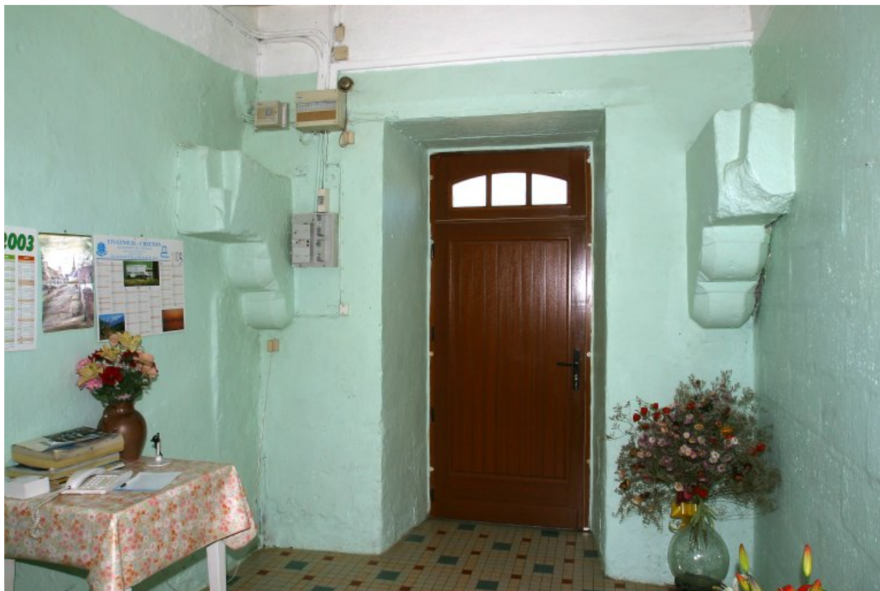
Le logis, vue intérieure. Vestiges de la cheminée.
