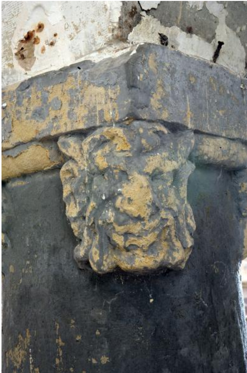
La cuisine en sous-sol, détail d'une colonne sculptée.
