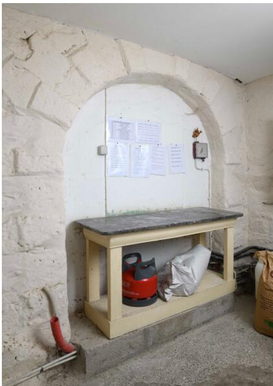
Détail de la porte en plein-cintre à bossage sur le mur pignon est.
