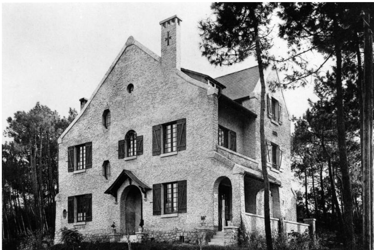
Façades nord-est et nord-ouest de la villa Saint-Hubert.
