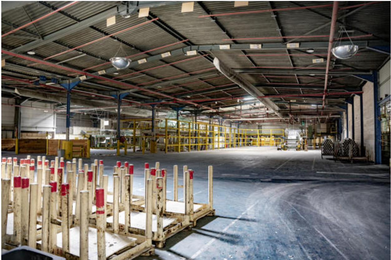
Vue intérieure partielle de l'atelier de finition O.
