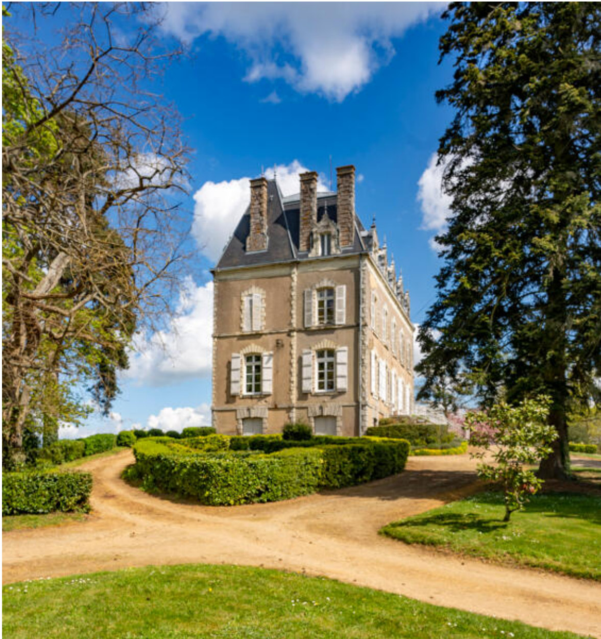
La façade latérale ouest.
