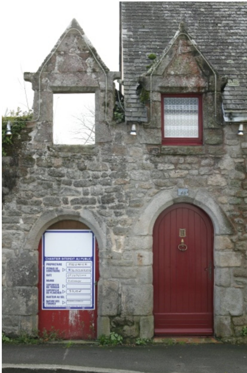
Façade sur rue, détail des portes et lucarnes.
