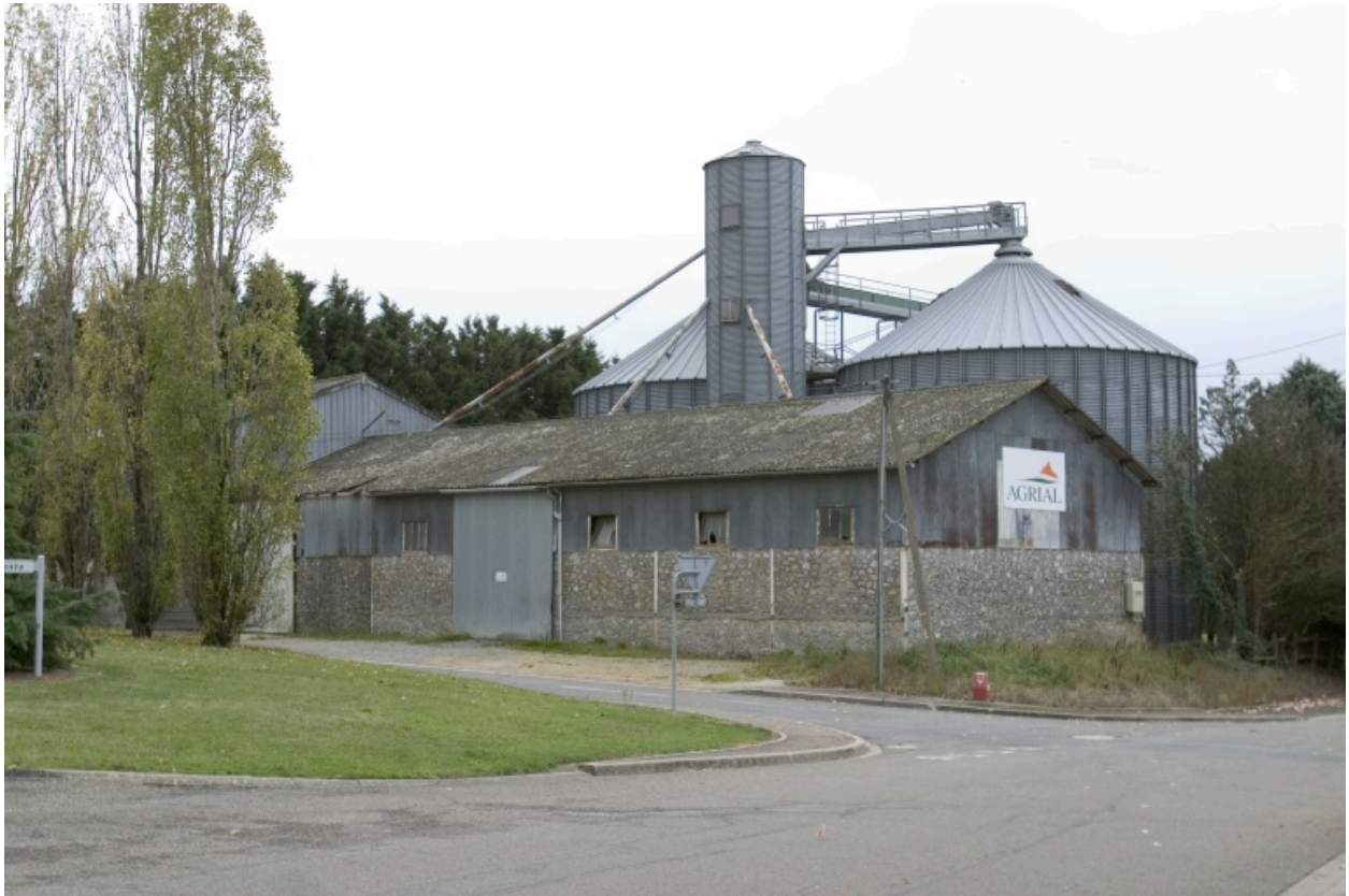
Vue d'ensemble depuis la route de la Bazouge au nord-ouest.
