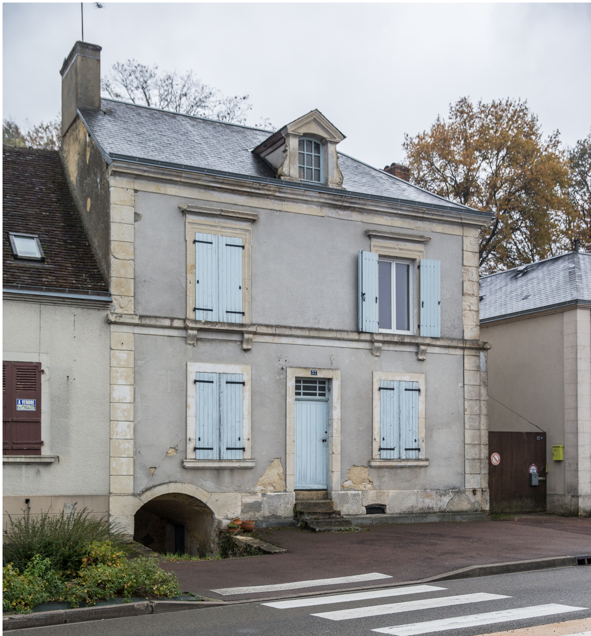
La façade principale.
