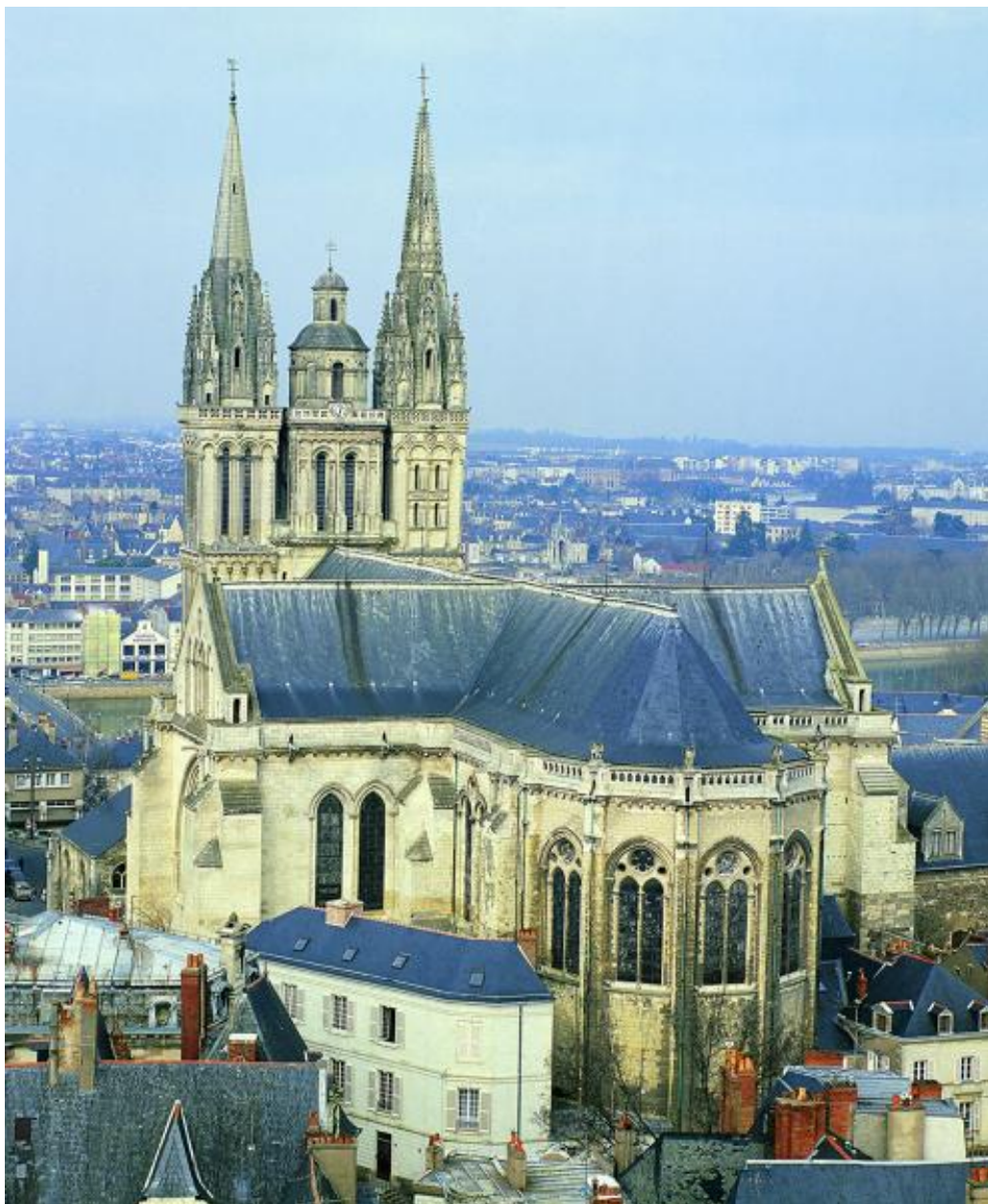
Ensemble, du sud-est.
