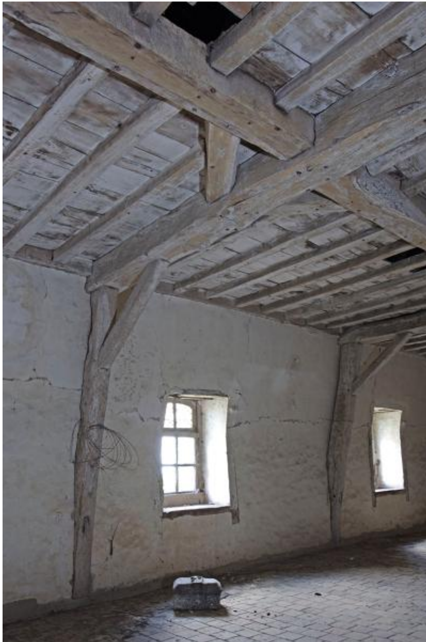
Le corps de commons dit "grange d'abondance", premier niveau de comble.
