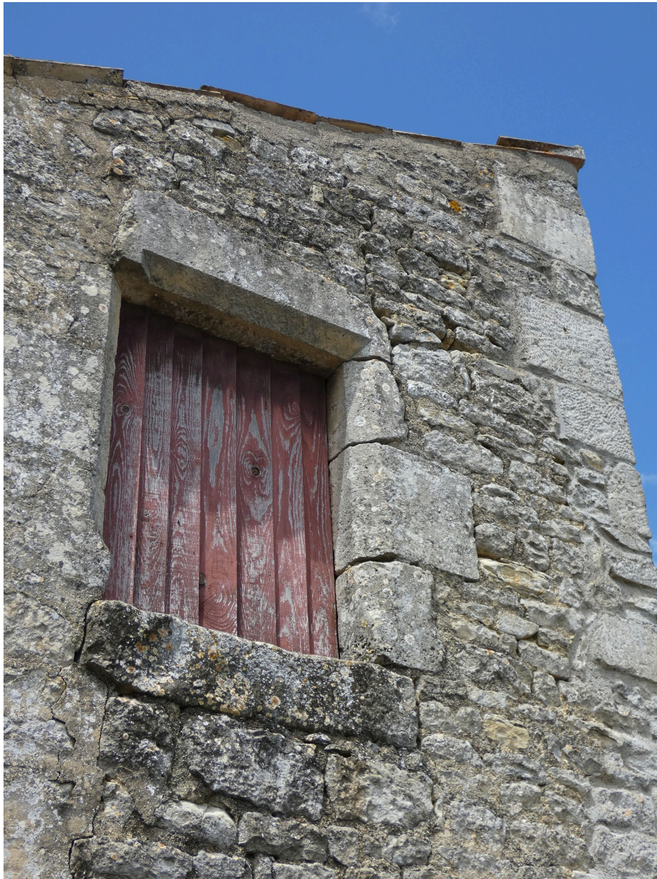
La baie de la remise, à encadrement chanfreiné.
