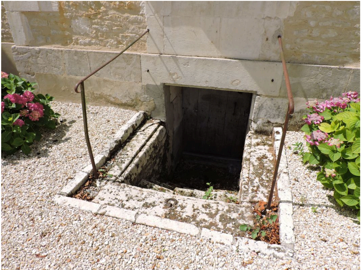
La descente de cave au pied de la façade côté cour.
