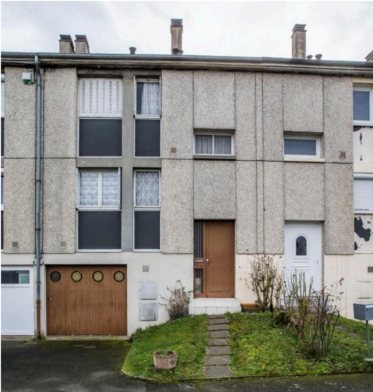
Assemblage de béton et pierre reconstituée sur la façade d'une maison.
