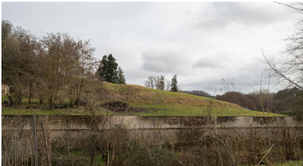
Mur de clôture, vu depuis le sud-ouest.
