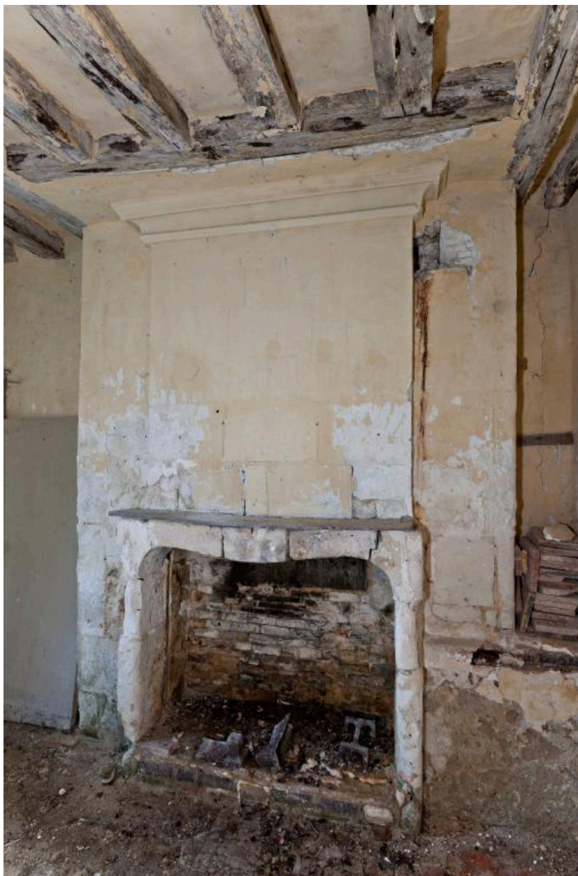
Dépendance 1, RdCh, pièce à feu : cheminée.
