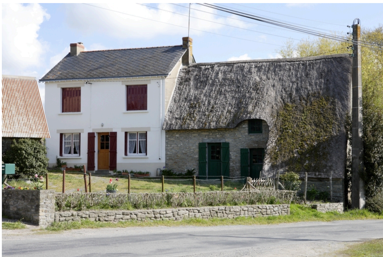
Vue d'ensemble depuis le sud.
