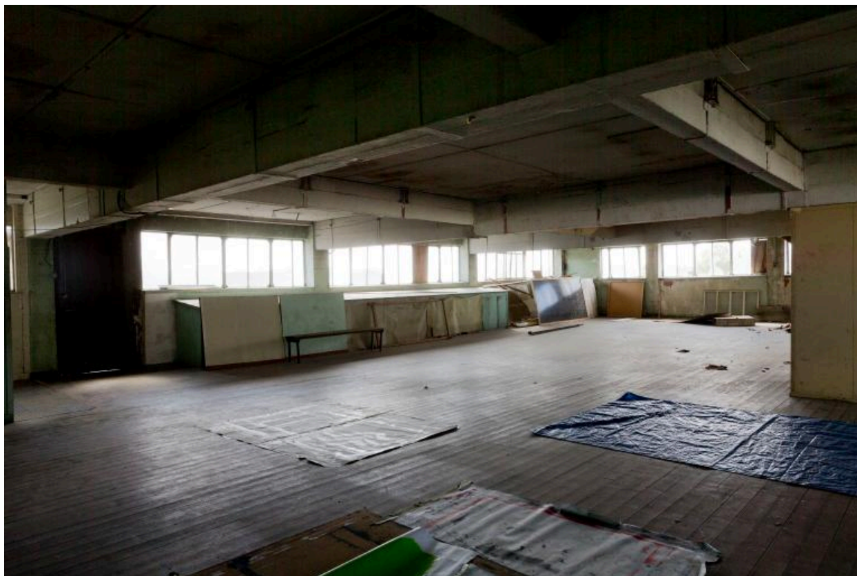
Salle à tracer : 1er étage.
