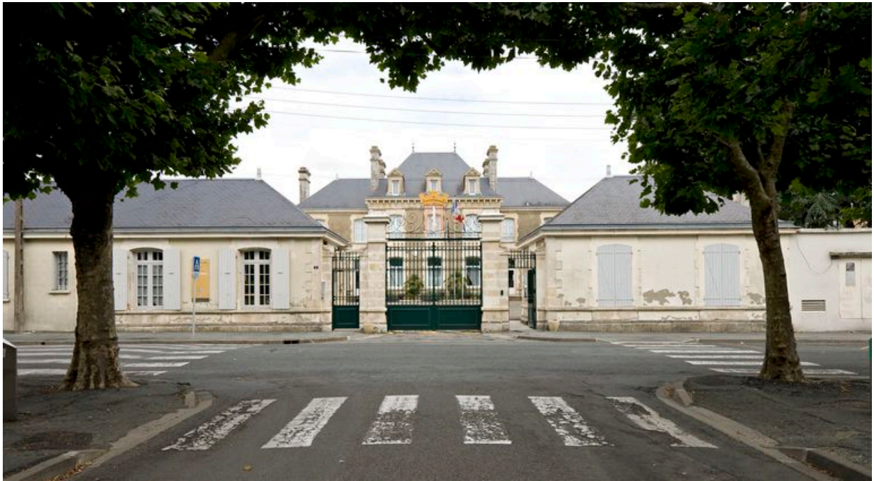
Vue prise de la rue Jean-Jaurès.
