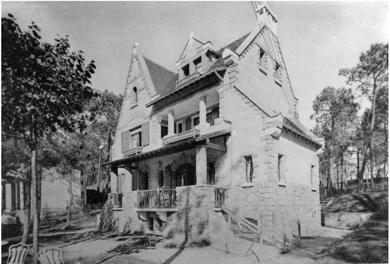
Façade sud de la villa Kenavo vue du sud-est.
