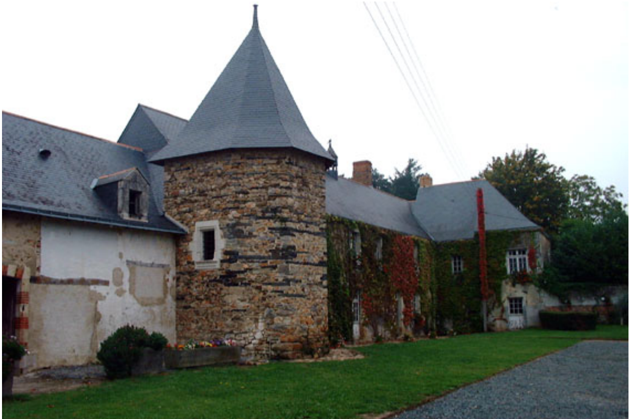
Vue d'ensemble de la façade sud du logis depuis l'est de la cour.
