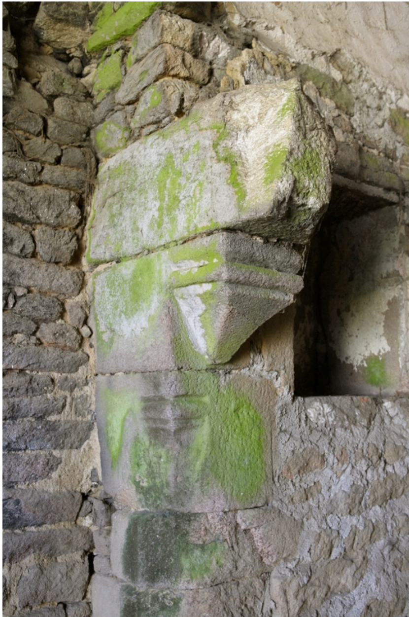
Détail du corbeau droit de la cheminée du 1er logis.
