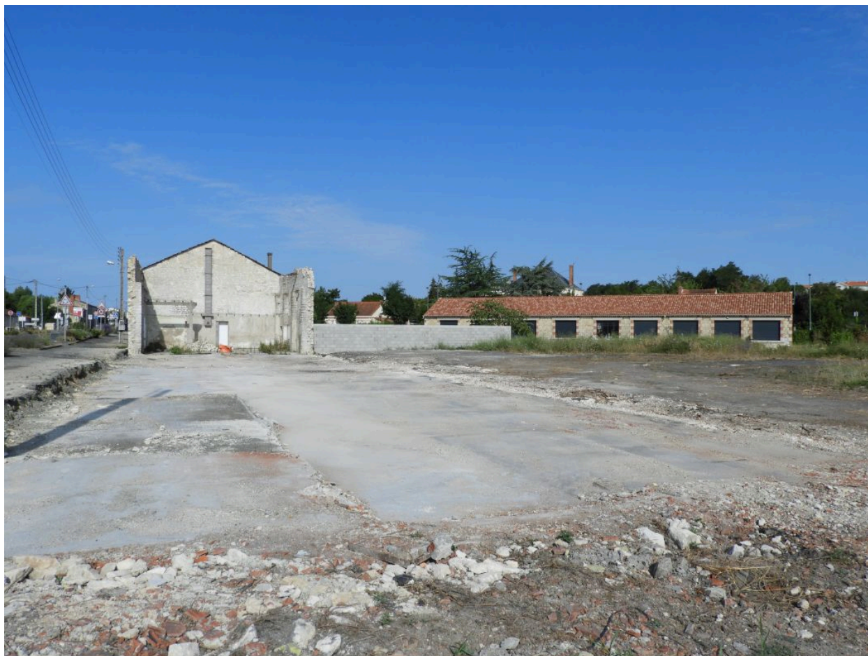
Les vestiges de l'usine vus depuis l'est.
