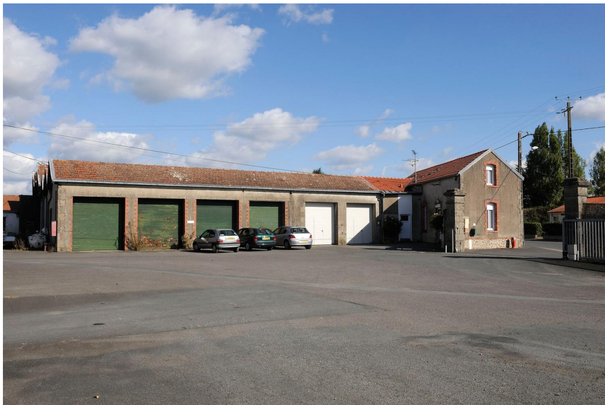
Vue extérieure du bâtiment de stockage et garage.
